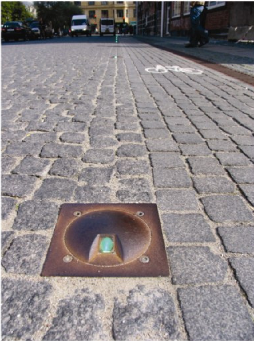
Pullerter og lys i belægningen kan markere vejforløbet.
